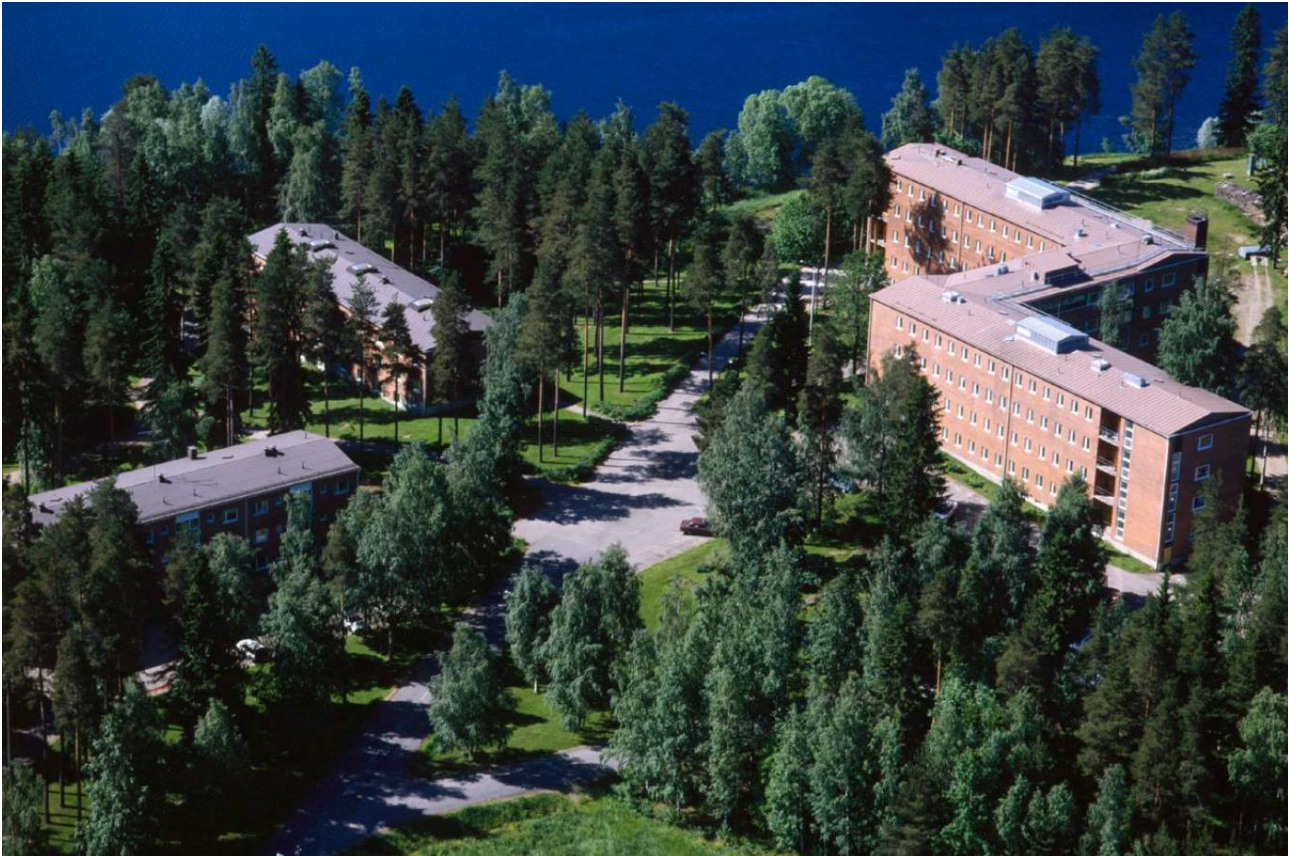
Kuva 8 Kuva sairaalasta 1980-luvun lopulta, kun koneellisen ilmanvaihdon konehuoneet oli rakennettu, mutta hissitorneja ei ollut vielä aloitettu. Kuvälähde: Keski-Suomen museo.
